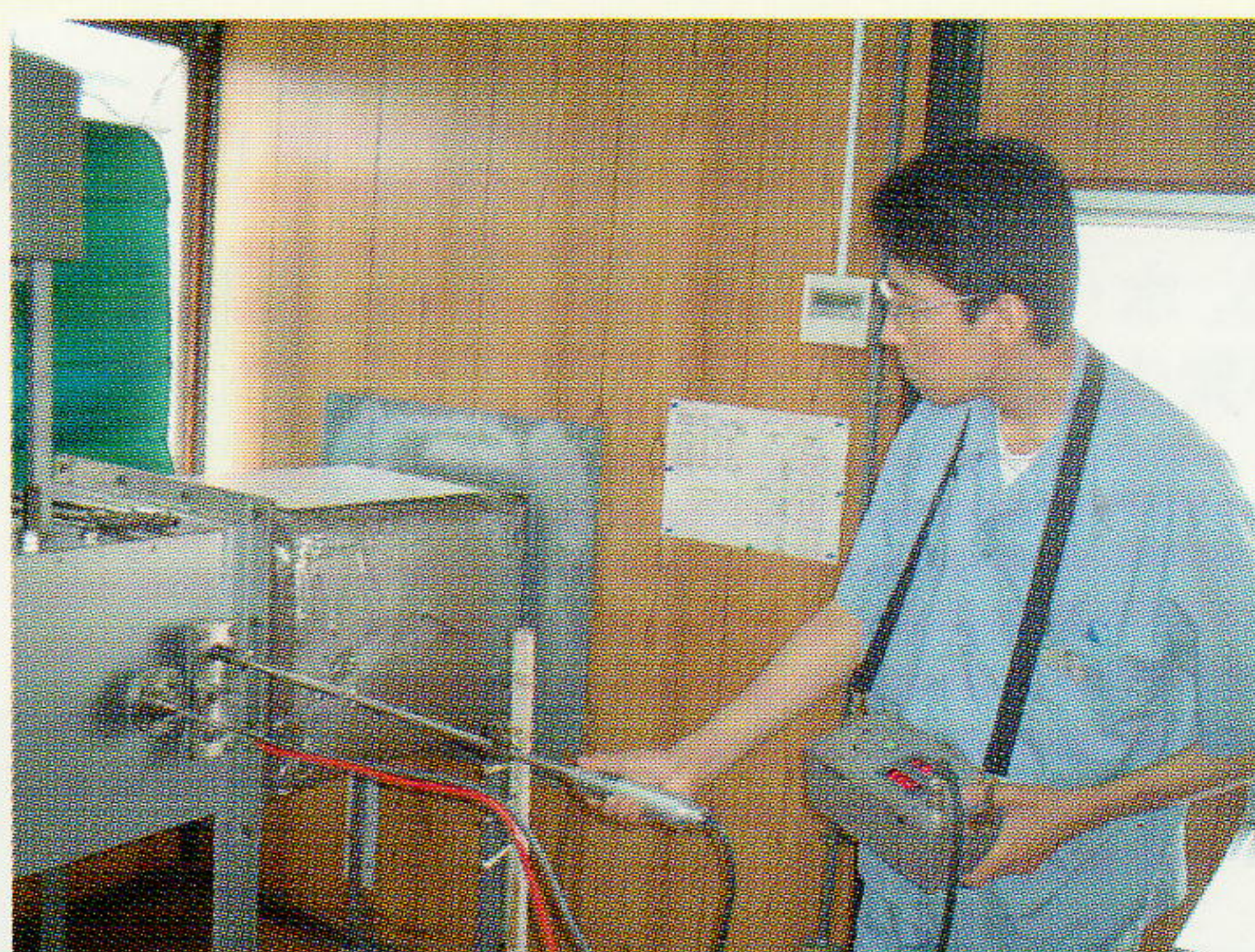
排気ダクトの測定に
